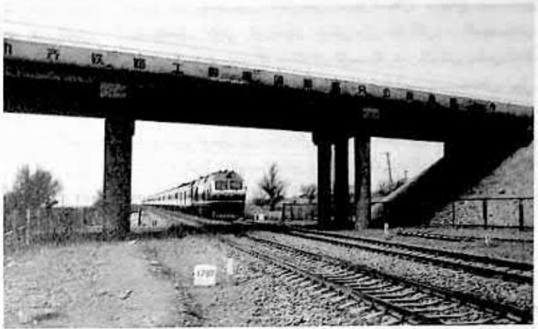
2002 - يىلى ئۈرۈمچى تۆمۈريول ئىدارىسى لەنجۇ - شىنجاڭ تۆمۈريولى لىنىيىسىنىڭ سۈرئەت ئاشۇرۇلغان بۆلىكىدىكى 18 يول ئېغىزىنى ئۆتۈشمەلىك قىلىپ ئۆزگەرتتى. سۈرئەتتە ئۆتۈشمەلىك يول ئېغىزى لى يىلىۋوتوسى
