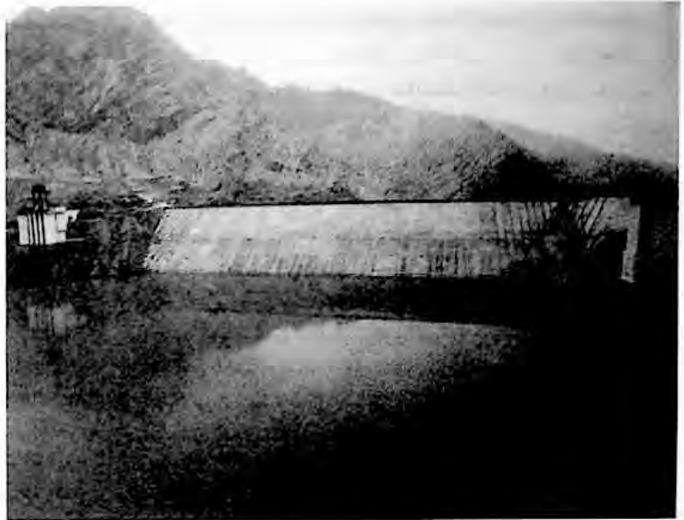
ئۇلۇغشاتا تۈگۈنلۈك سۇچىلىق قۇرۇلۇشنىڭ ئامبار رايونى ۋە باش تومبا
