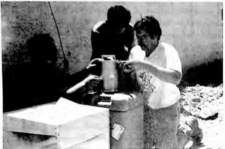
جۇڭگو - ئامېرىكا تەجرىبىنىڭ يەر شارى دىنامىكىسى ئۈستىدە تەتقىقات، ھەمكارلىق تۈرىنىڭ ئامېرىكا تەرەپ مۇتەخەسسى پروفېسسور سىتېۋېن ئاقچى ناھىيىسىنىڭ قاراجى يېزىسىدا سېسېمىئوگرافى ئورۇنلاشتۇرماقتا. شۇ يىلى فوتوسى
