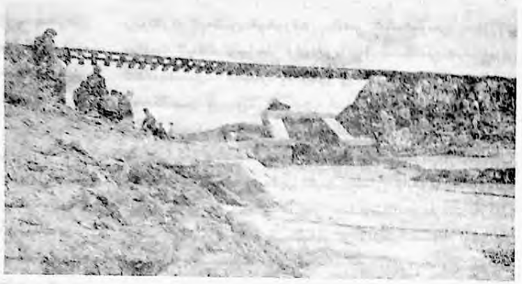
1992 - يىلى 7 - ئاينىڭ 19 - كۈنى قۇمۇل شۆبە تۆمۈريول ئىدارىسىگە قاراشلىق 200 كىلومېتىردىن ئۇزۇن لىنىيىنىڭ 42 يېرى سۇ ئاپىتىنىڭ تەسىرىگە ئۇچرىدى، توققۇز جايدا رېلىس ئۆلىمى قالى.
