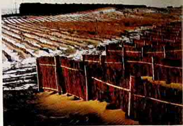
شامالدىن مۇداپىئە كۆرۈپ قۇمنى تۇراقلاشتۇرۇپ، تۇمۇر يولىنىڭ رايۇنلىقىغا كاپالەتلىك قىلىش «شىنجاڭ» رەسىملەر ئويلىمىدىن ئېلىندى
